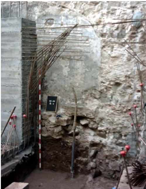
Sondeig 4. vista de l'alçat del mur u.e. 403 amb l'arc de descàrrega u.e. 404.
